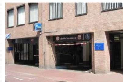
Fietsenstalling Den Bosch - Wolvenhoek / De Kuil
