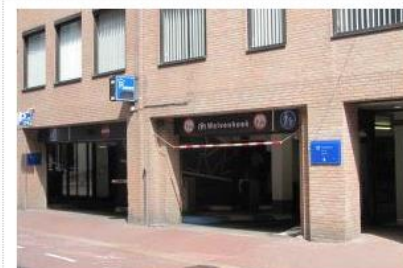
Fietsenstalling Den Bosch - Wolvenhoek / De Kuil
