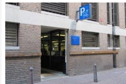
Fietsenstalling Den Bosch - Burgemeester Loeffplein
