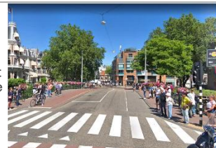
Voorbeeld brede verkeersbrug, Museumbrug Amsterdam
