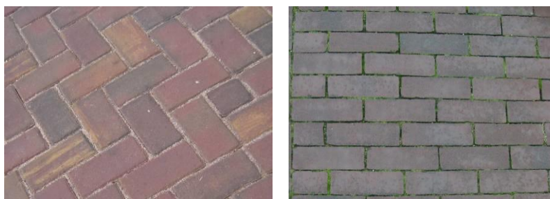
figuur 5 Links een elementenverharding in keperverband, rechts in halfsteensverband.
